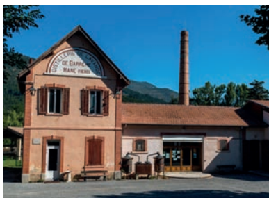
Distillerie de Barrême
